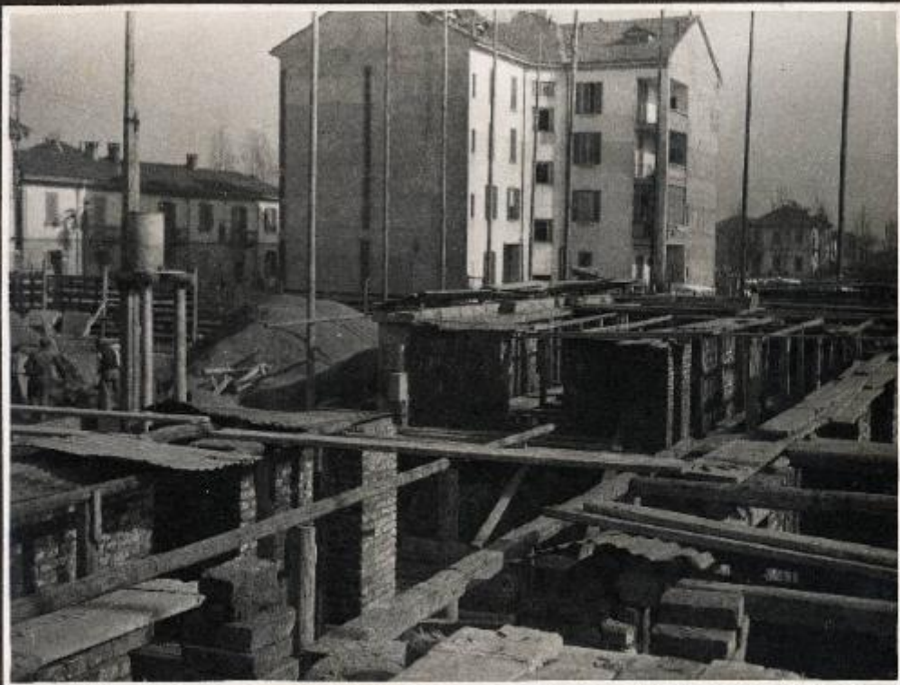
Il palazzo comunale in costruzione
