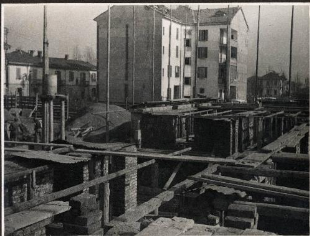
Il palazzo comunale in costruzione
