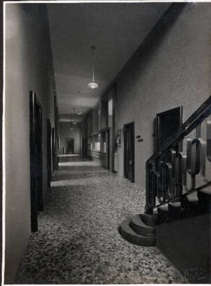
La galleria per il pubblico al piano terreno
