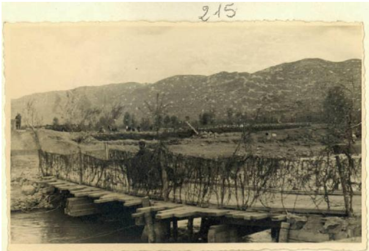
ponte sul Devoli tra Korcia e Bilisht
