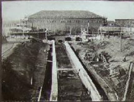
Vista da valle durante la costruzione dei muri Vala e del muro di sostegno dell'acqua.
