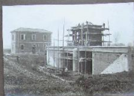
Viola da valle dinanzi la porta del tetto del Casello per i meccanismi di manovra e casa del guardiano.
