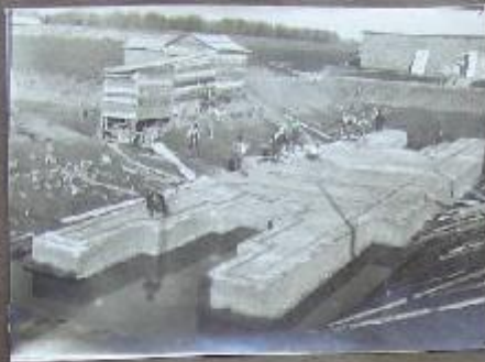
Forata di fondazione al distacco dei muri
