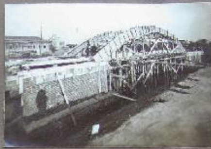
Centinatura ed armatura dei ferri vista di fianco
