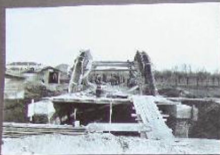
Losa dei ferri
