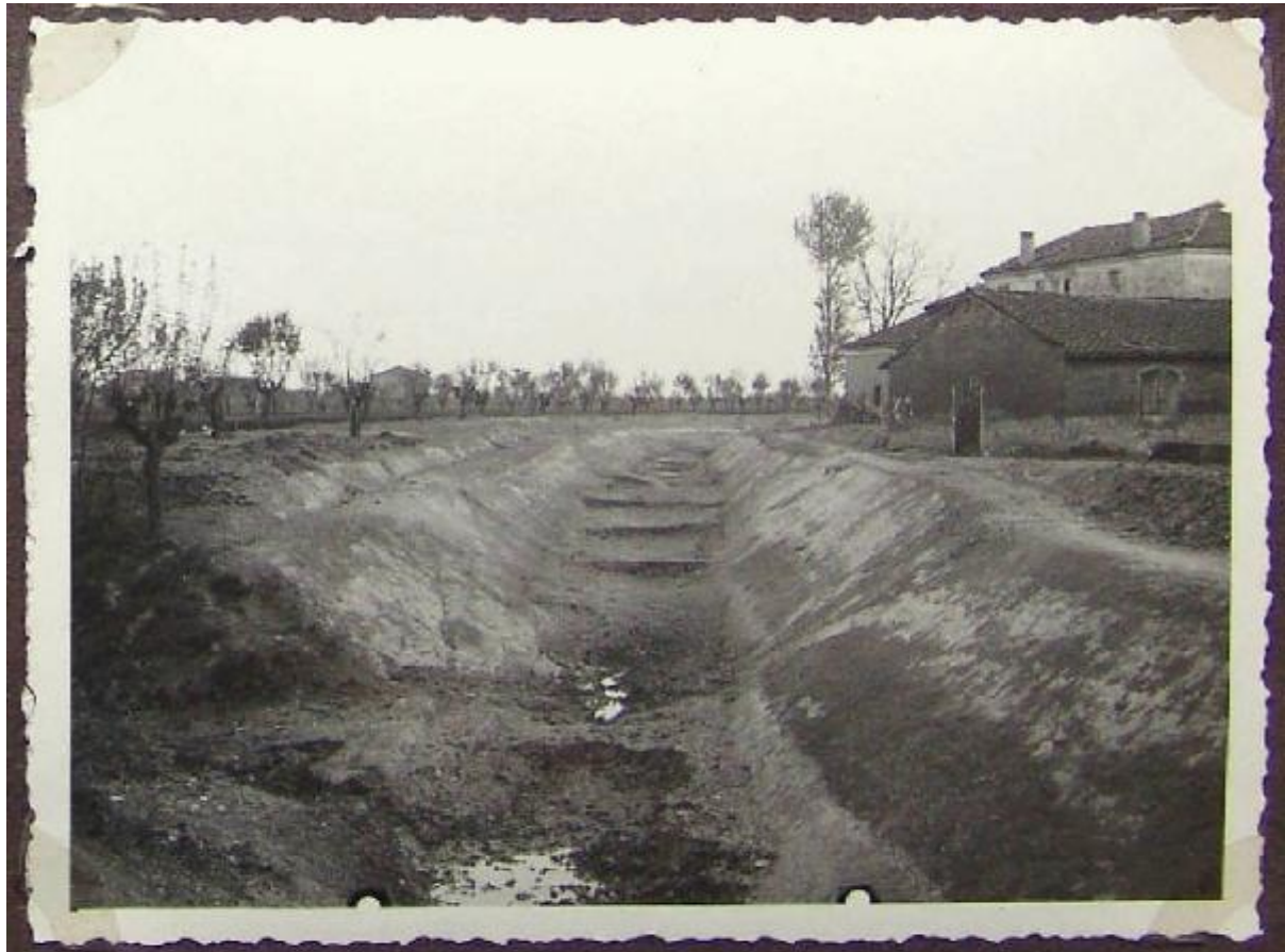
Canale Beccaguda (Sistemazione presso il Collettore)
