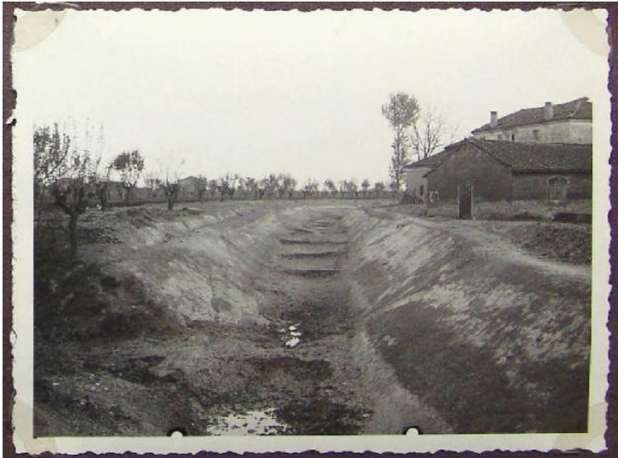
Canale Beccaguda (Sistemazione presso il Collettore)
