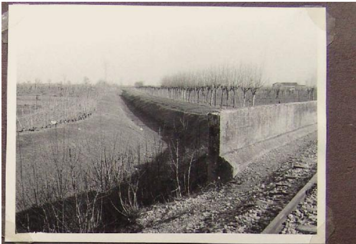
Fossa Comune a) (ed valle del ponte ferroviaria Martora - Moolena)
