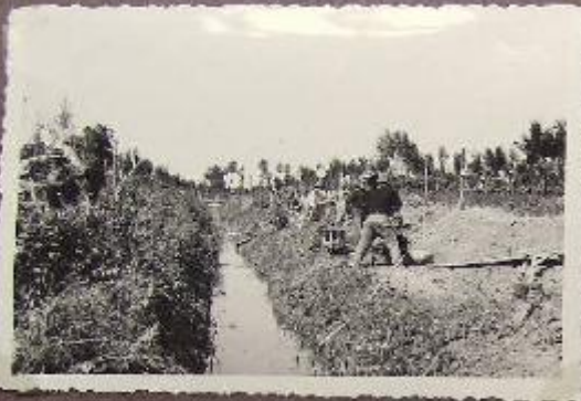
Canale Salimada (Lavoro di escavo)
