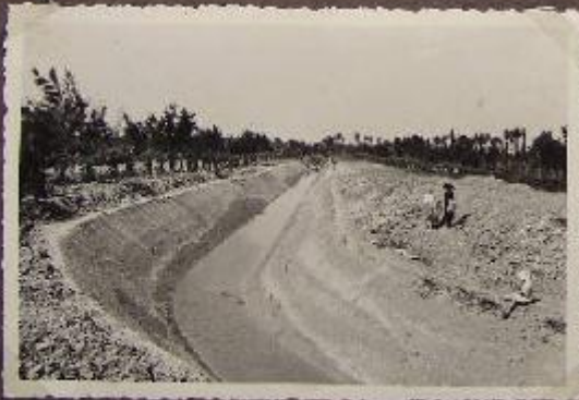
Canale Salimada, (Sistemazione verso la fitta)
