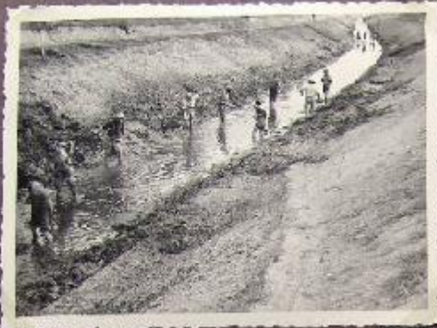
Canale Sparzacamagna Sin. ta (1° corso)
