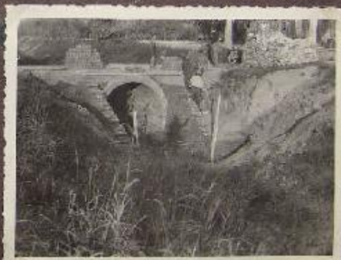
Canale Fossetta Campolungo (Ponte Loggione Bertolotto)
