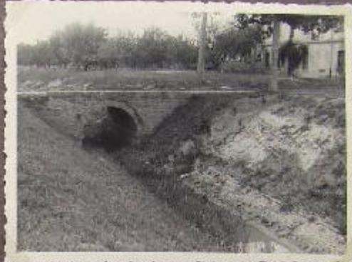
Canale Fossetta Campolungo (Ponte Loggione Bertolotto)
