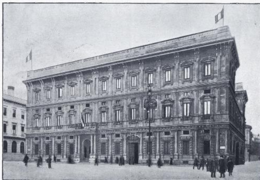
PALAZZO MARINO. — La facciata verso Piazza della Scala.
