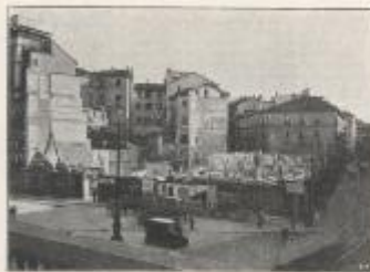
Visuale d'interno delle demolizioni per la costruzione del nuovo palazzo della Banca Commerciale Italiana, 1943.
