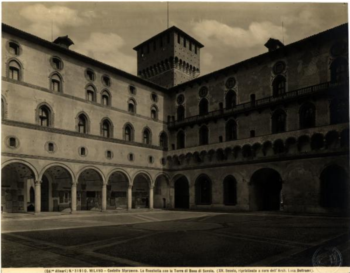
(Ed. Attuari) N.° 31910. MILANO - Cesello Sforzesco. La Rocchetta con la Torre di Base di Savola. (XV. Secolo, ripristinato a cura dell'Arch. Lisa Beltrami).
