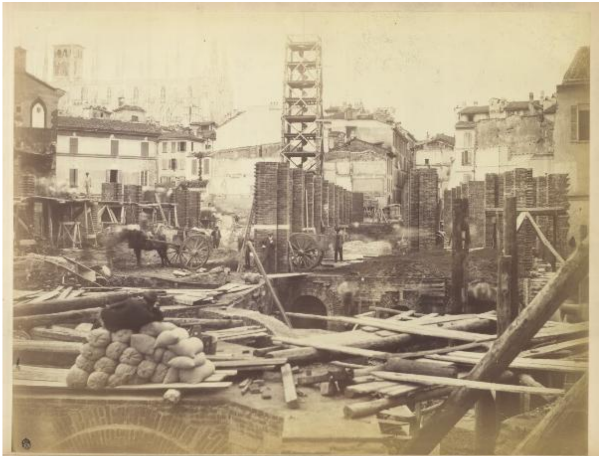
PROGETTO MENGONI PER LA NUOVA PIAZZA DEL DUOMO GALLERIA VITTORIO EMANUELE, e sistemazione delle Vie adiacenti a MILANO Stato dei lavori della Galleria Vittorio Emanuele 1868
