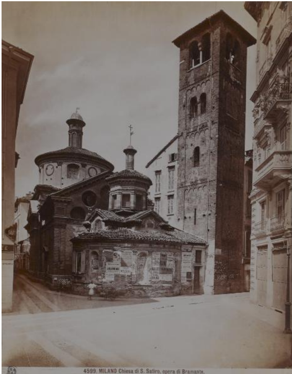
4599. MILANO Chiesa di S. Satiro, opera di Bramante.
