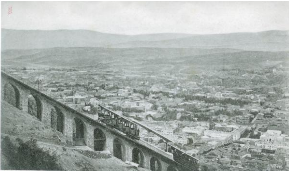
Тифлисъ. Средна Станция фуникулера - Tiflis. Station du milieu du funiculaire.
