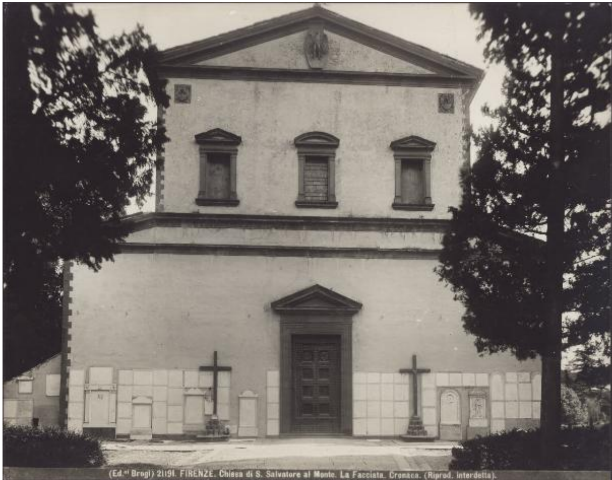
(Ed. Brogi) 21191. FIRENZE. Chiesa di S. Salvatore al Monte. La Facciata. Cronaca. (Riprod. interdella).
