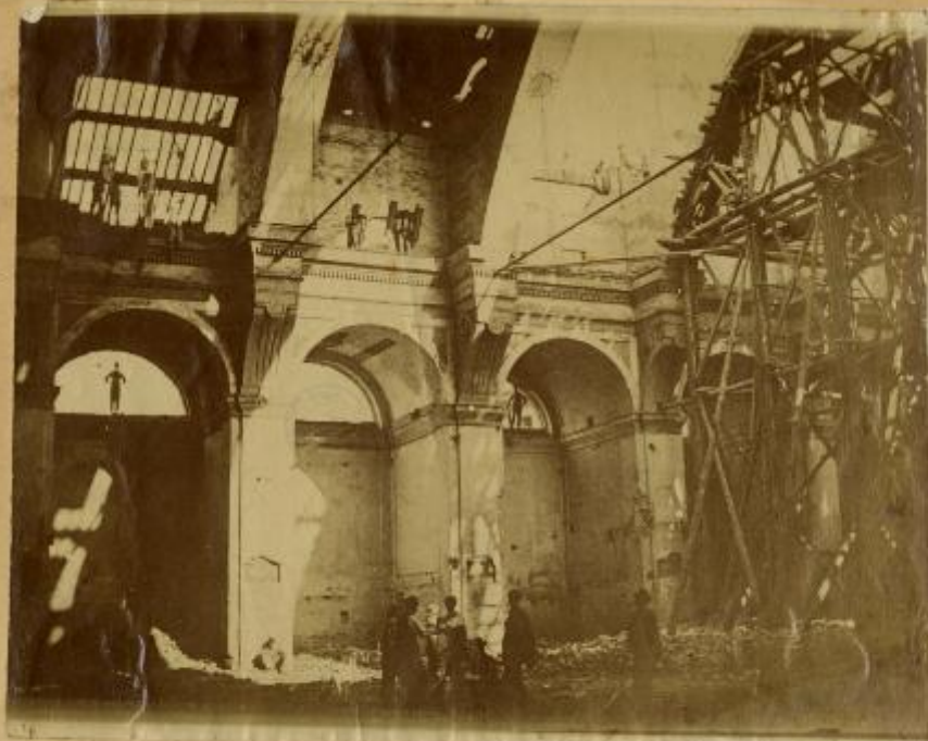
- S. Maria del Giardino - (Demolizioni)
