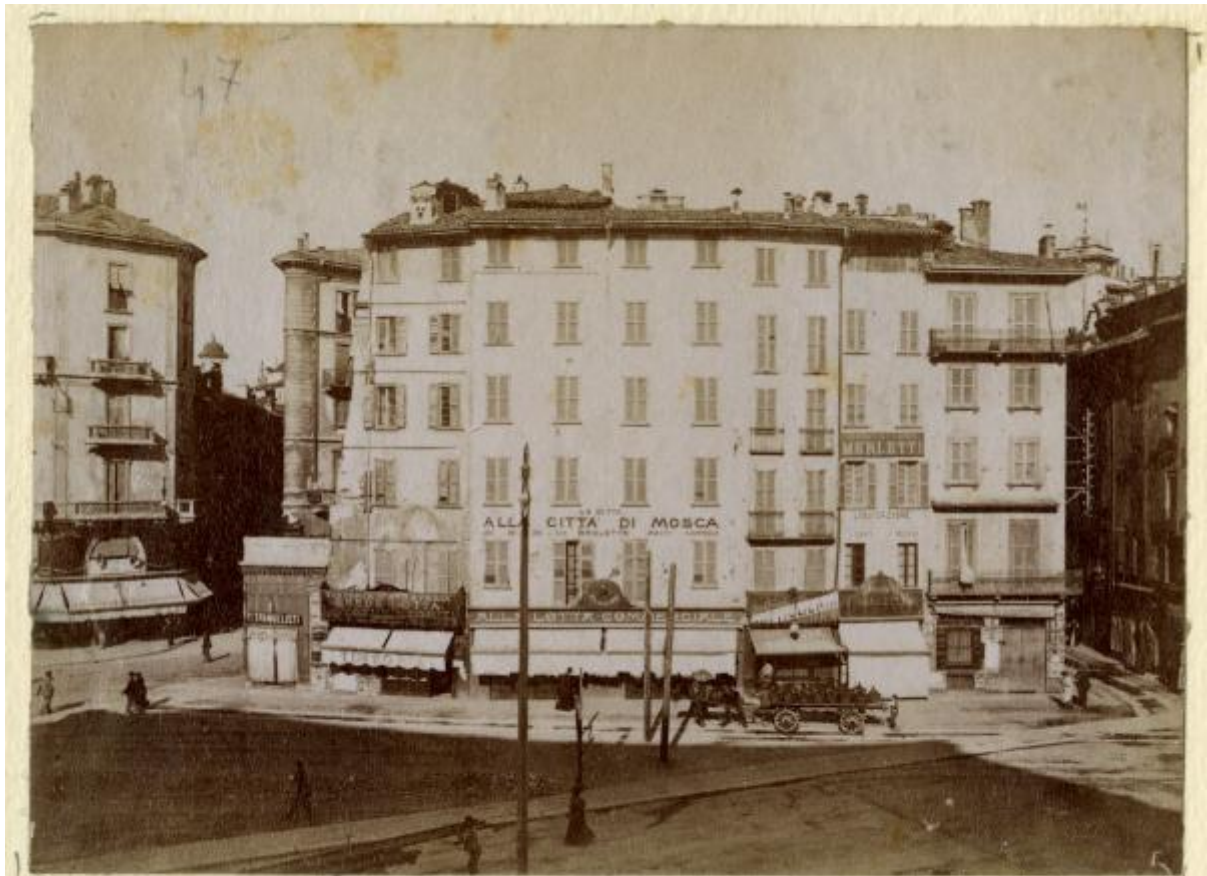
Bordusio verso via Crefici e via 47 Mercanti.
