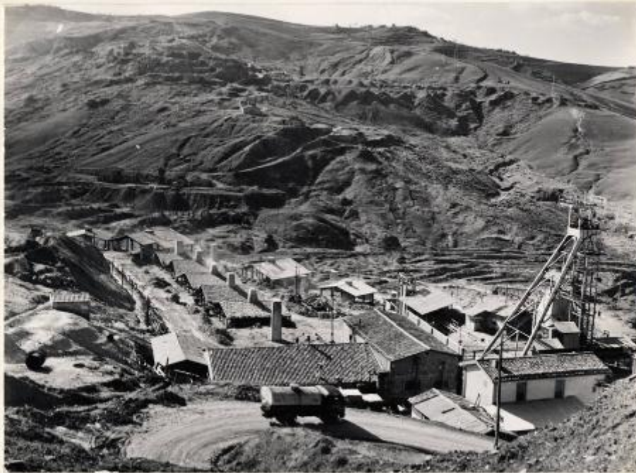
Foto n. 9465 - Veduta generale della miniera
