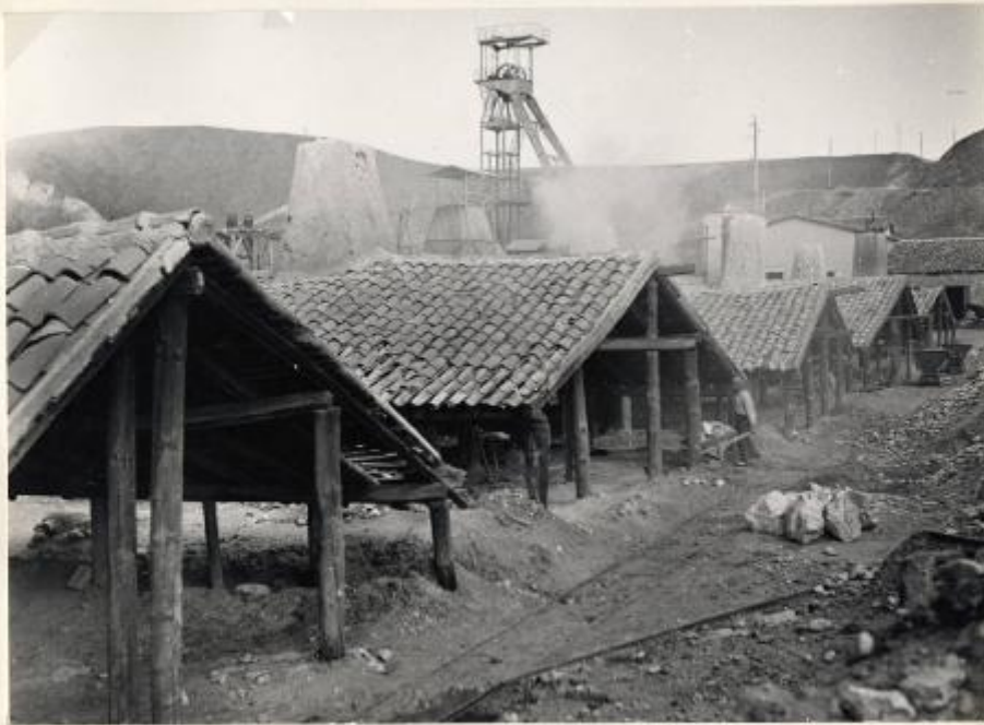
Foto n. 9491 - Forni per trattamento minerale
