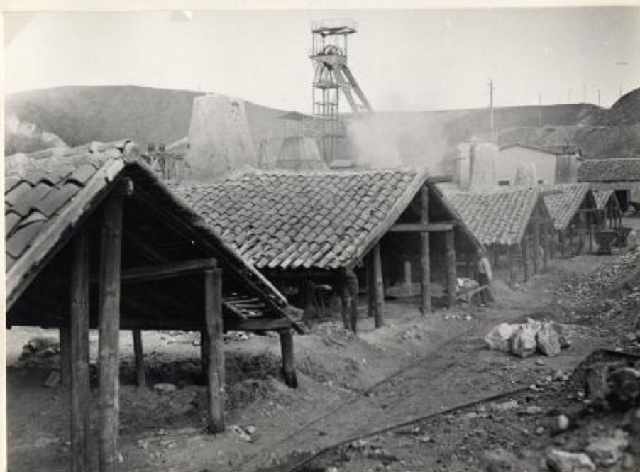
Foto n. 9491 - Forni per trattamento minerale
