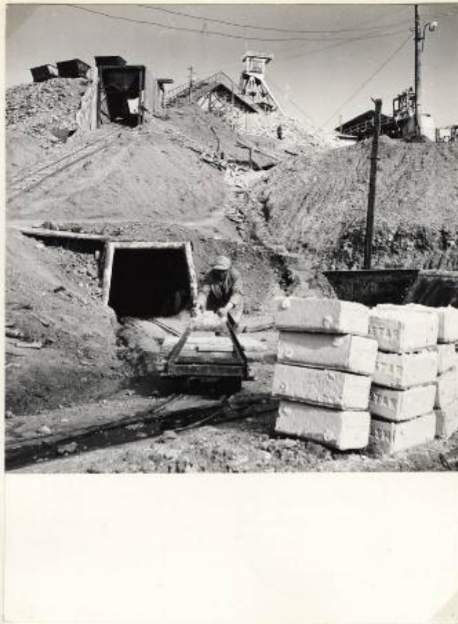
Foto n. 9479 - Pozzo di estrazione; pani zolfo
