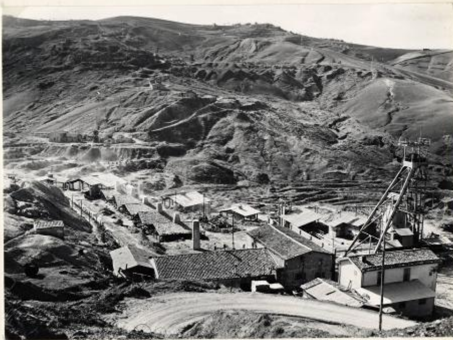
Foto n. 9466 - Veduta generale della miniera
