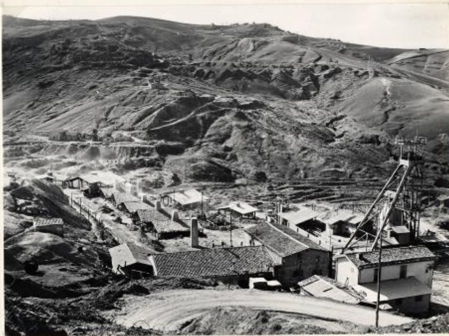
Foto n. 9466 - Veduta generale della miniera
