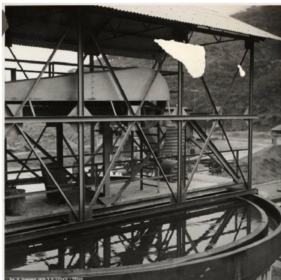
Fig. V. - Ingresso della S. R. Ciriale - Milano
