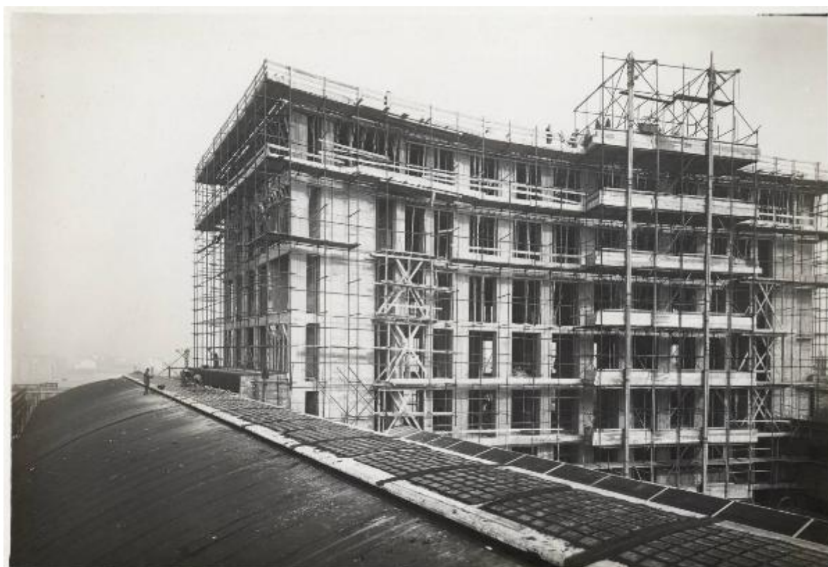
NUOVO PALAZZO UFFICI
