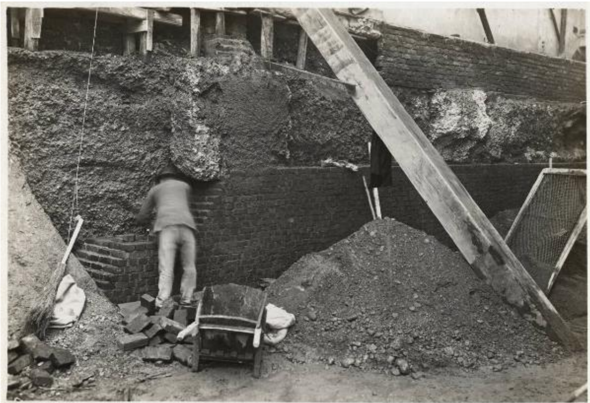
NUOVO PALAZZO UFFICI (30) Sottomurazione del palazzo esistente 24-dicembre-1936
