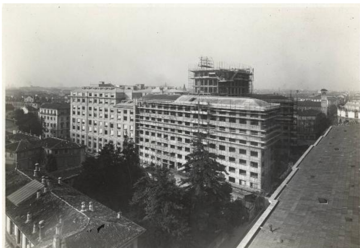
NUOVO PALAZZO UFFICI
