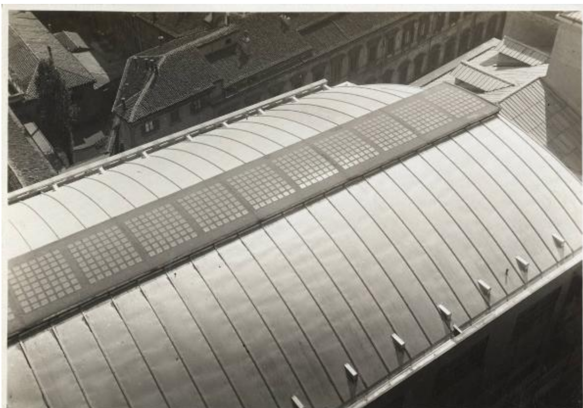
NUOVO PALAZZO UFFICI (273) Tetto in alluminio sopra il corpo D 2 Aprile 1938
