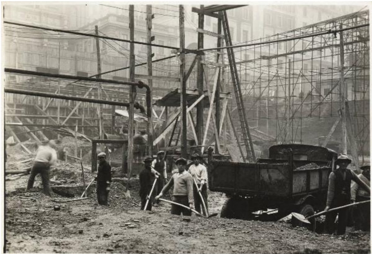
NUOVO PALAZZO UFFICI (35)
