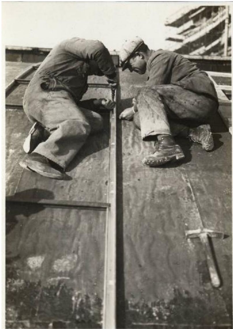
NUOVO PALAZZO UFFICI (232) Tetto in alluminio - Posa dei profili 21 - Gennaio - 1938
