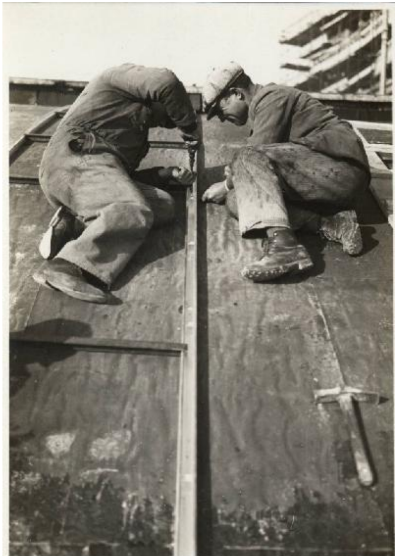
NUOVO PALAZZO UFFICI (232) Tetto in alluminio - Posa dei profilati 21 - Gennaio - 1938
