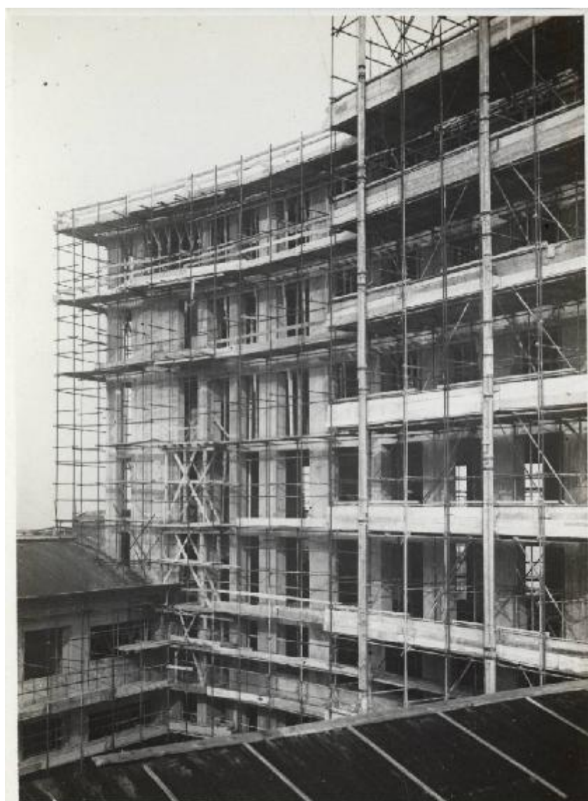
NUOVO PALAZZO UFFICI (178) L'ossatura del corpo centrale sopra i corpi bassi da Sud-Est B - Novembre - 1937
