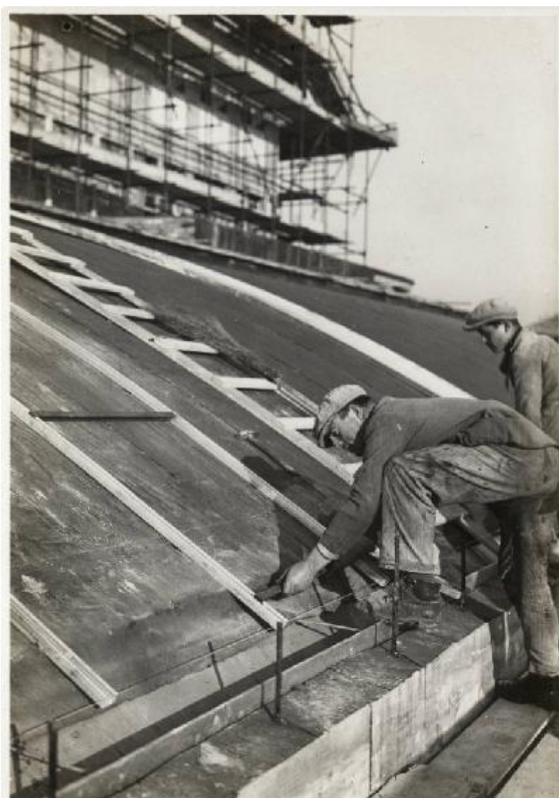
NUOVO PALAZZO UFFICI (231) Tetto in alluminio - Posa dei profilati 21 - Gennaio - 1938
