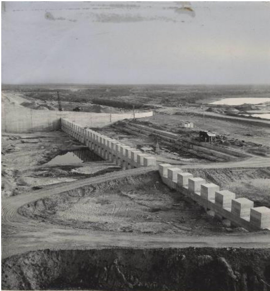
DIQUE DE RIO HONDO
