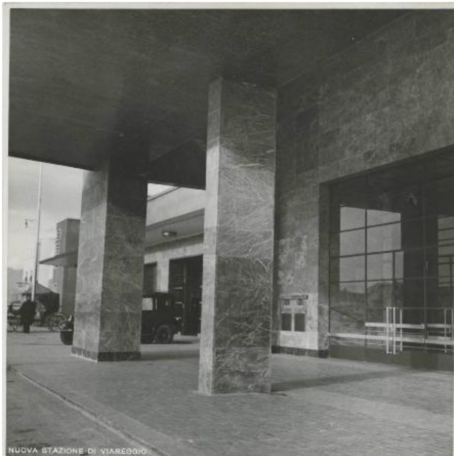
NUOVA STAZIONE DI VIAREGGIO
