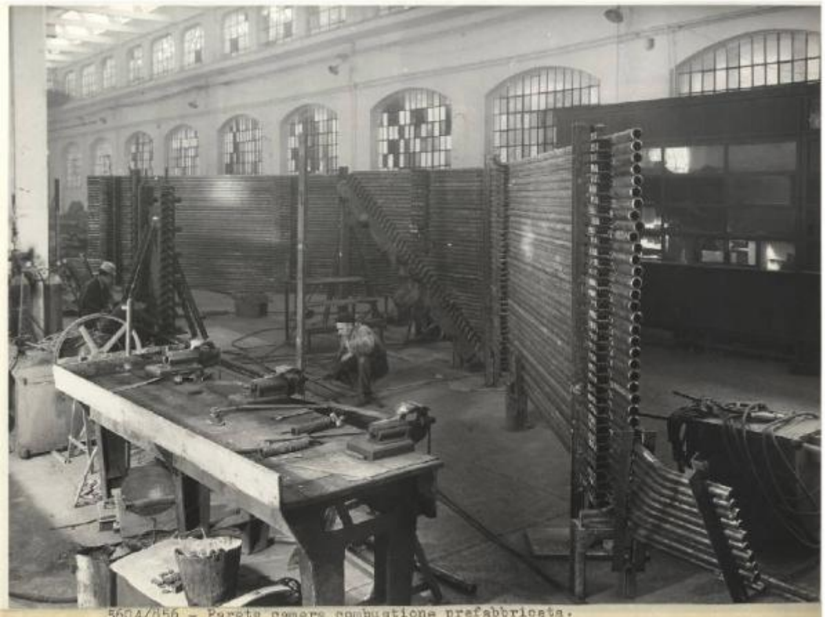
5604/856 - Parete camera combustione prefabbricata.
