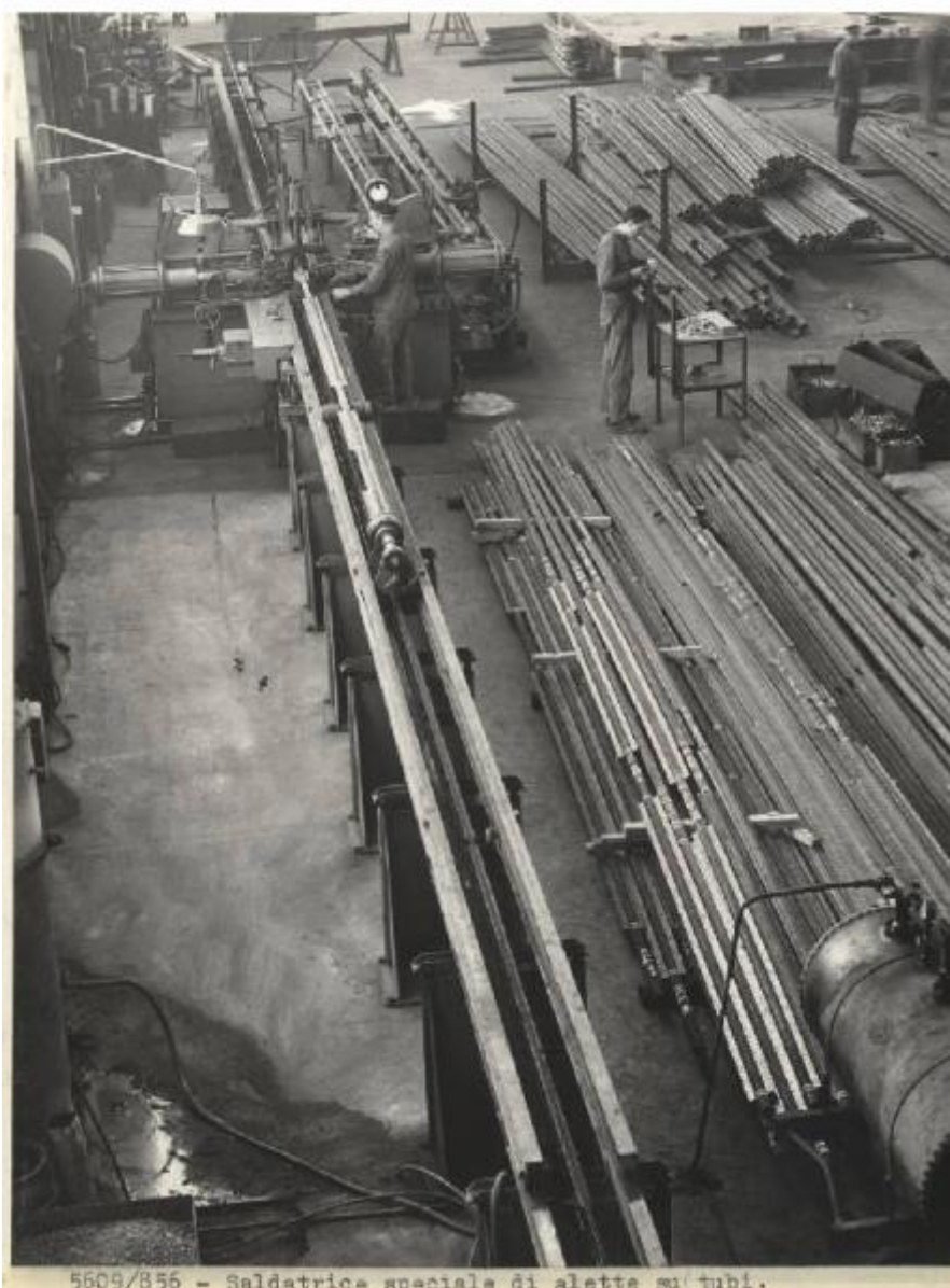
5609/856 - Saldatrice speciale di alette sui tubi.
