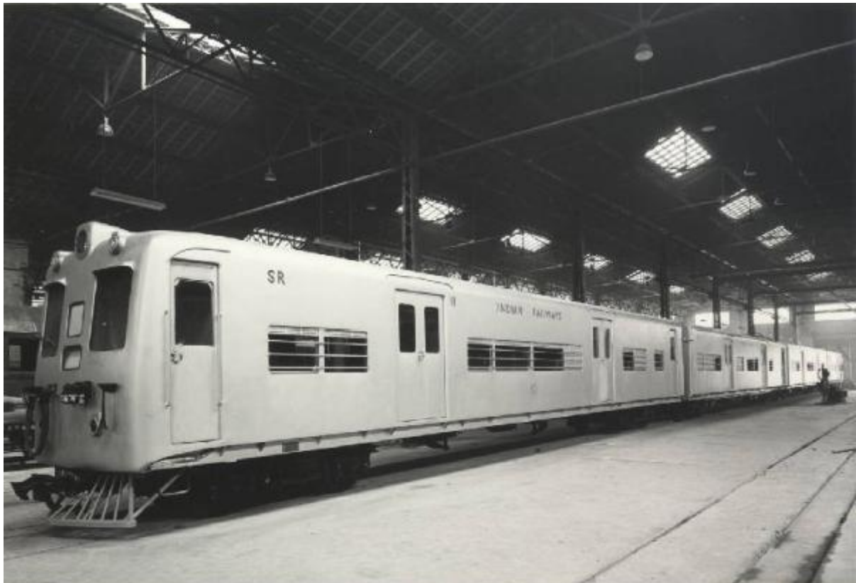
1955 - Treni elettrici multipli - Equipaggiamento elettrico per c.c.a 1500 V. con 4 motori da 170 CV. per Indian Railway - Ferrovie suburbane di Madras
