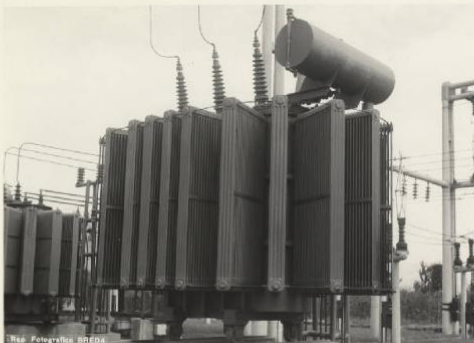
30. Anno 1947 - Società Elettrica Selt Valdarno - Centrale di Prato Trasformatore trifase 12.000 kVA - 62/10-9,5 kV - 50 Hz
