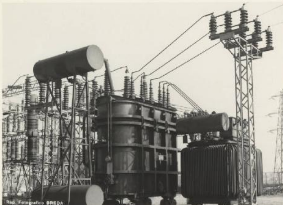
29. Società Ovesticino - Centrale di Alessandria Trasformatore trifase 26.500 kVA - 127/46,5+53,5 kV - 42 Hz con unità regolatrice sotto carico.
