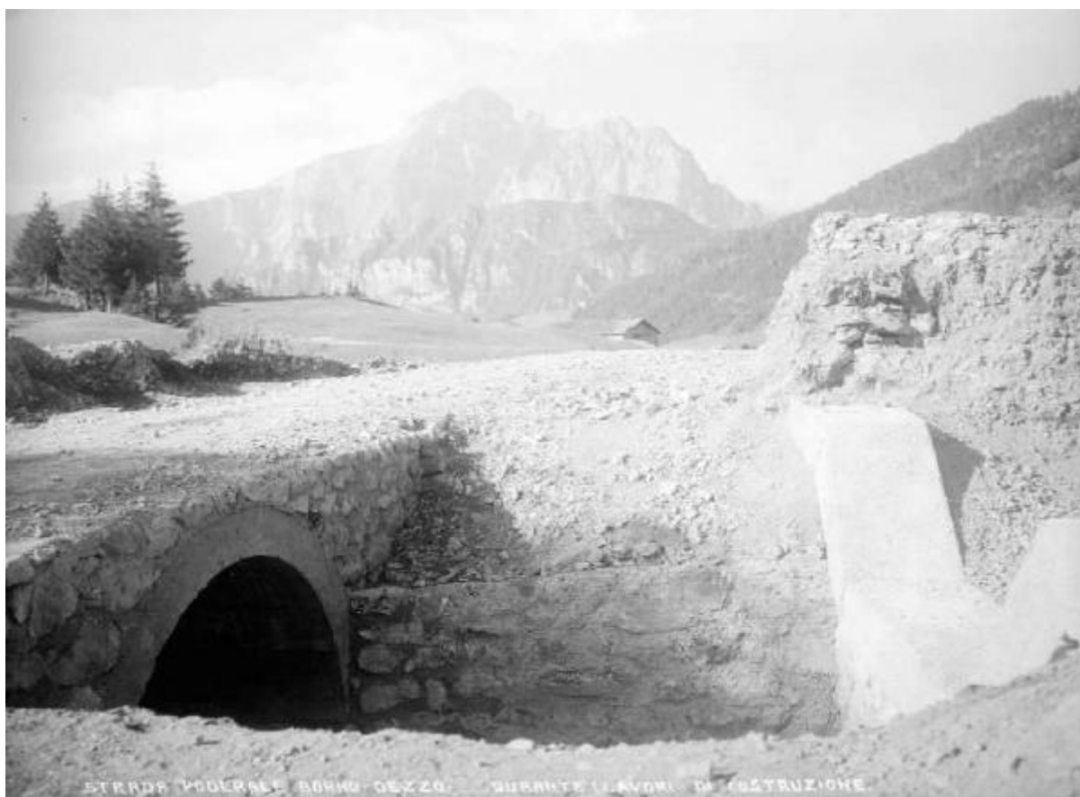
STRADA PROVINCIALE BOHNO-DEZZO. DURANTE I LAVORI DI COSTRUZIONE.
