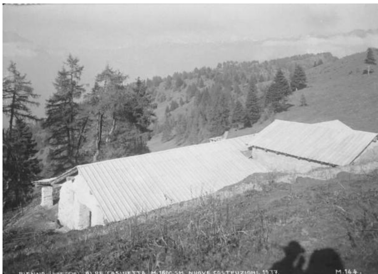
BIENNO (1937-38) - M. DE CASINETTA - M. 1600 S.M. NUOVE COSTRUZIONI - 1937.
