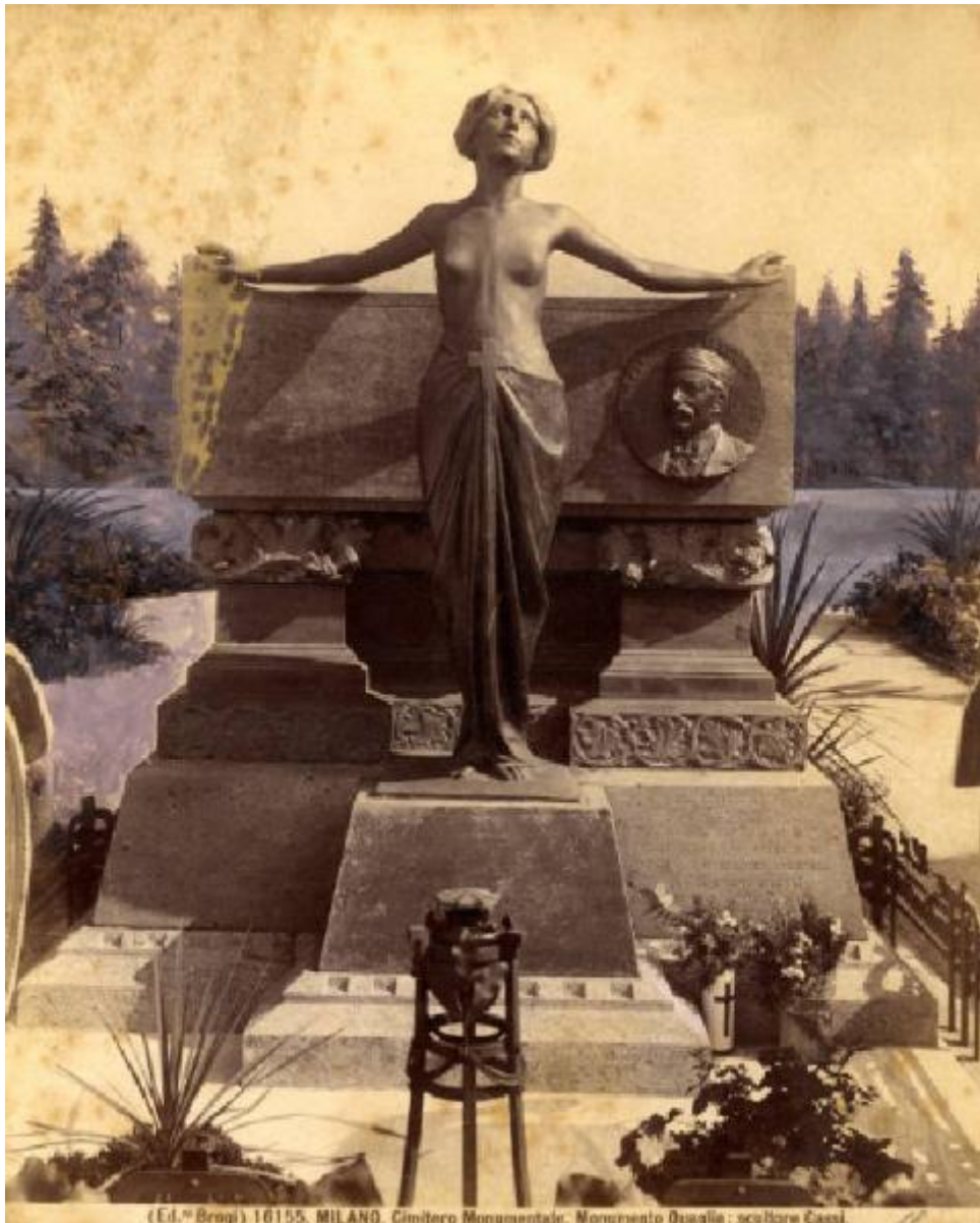
(Ed. Brogi) 10155. MILANO. Cimitero Monumentale. Monumento Quaglia; scultore Cassi.
