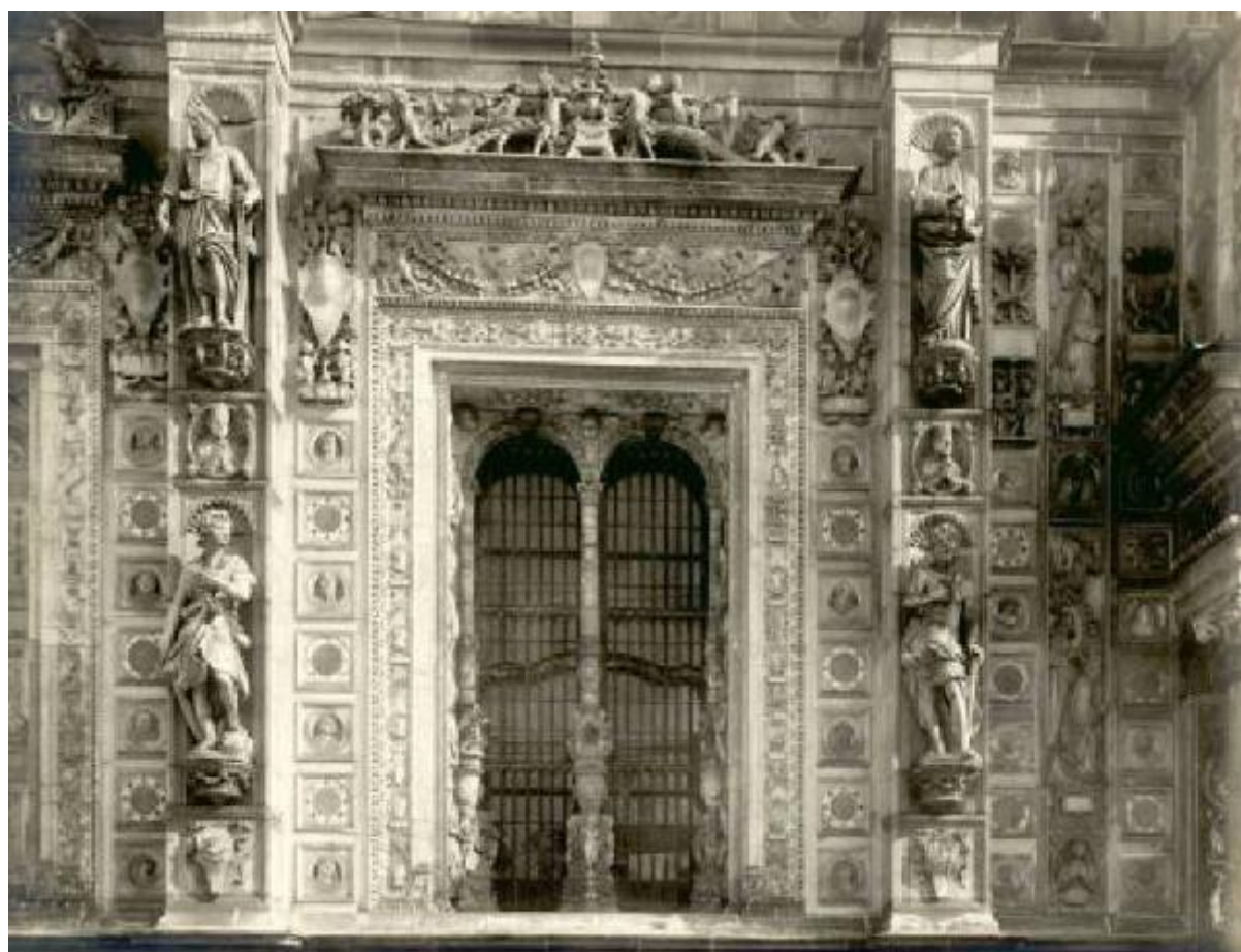
Isolone materello. PAVIA - Certosa - Finestroni della facciata - Francesco Villa. 0047
