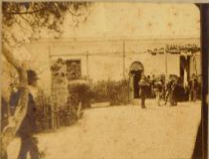
Veduta del Cortile della casa di Garibaldi.
